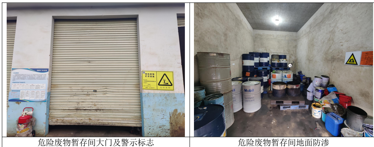
图 5.5-1 危险废物暂存间现场图
